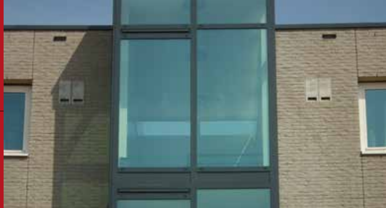
▲ De inbouwkasten in het sporthotel
